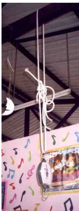
Figura 14b.- Balanza en una viga de techo
